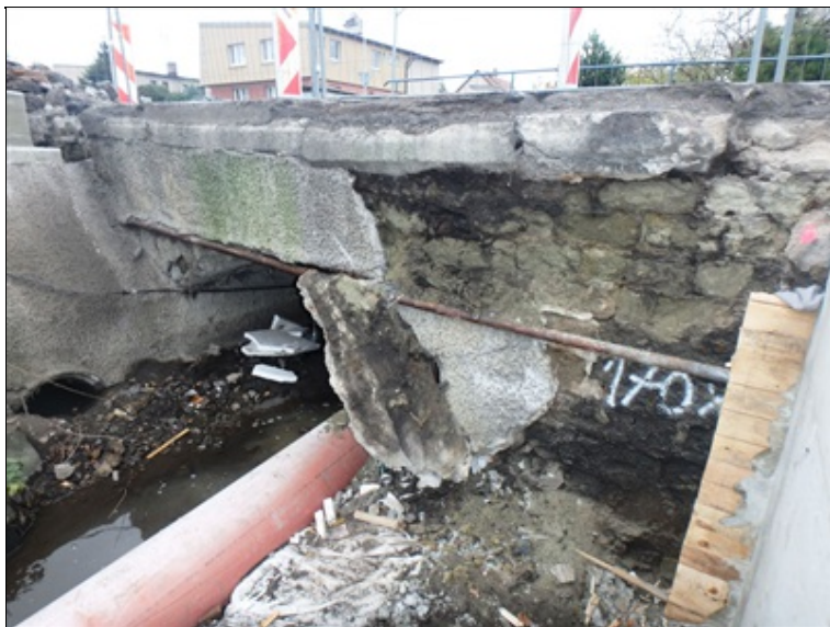
Levá strana mostu - rozpad torkretu, hloubková degradace zdiva klenby
