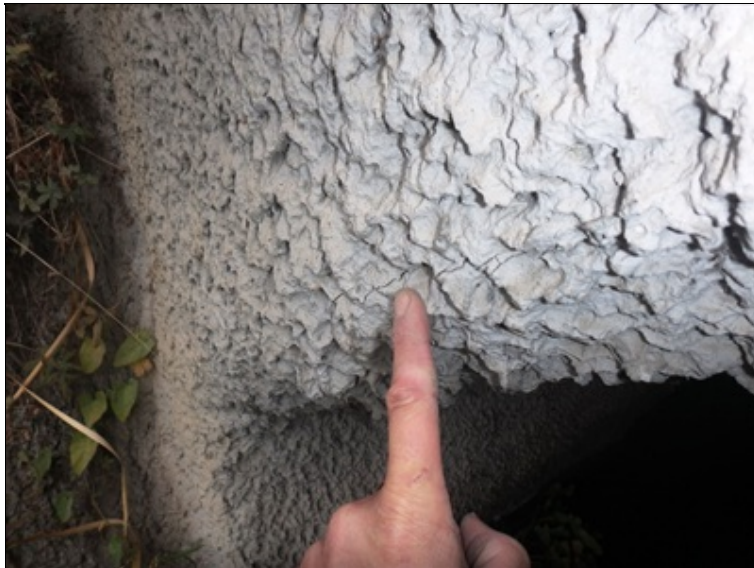
Pravá strana klenby - trhлина v torkretu podél spodní hrany
