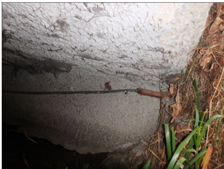
Pravá strana opěry Op2 - rozpad chráničky, obnažený kabel
